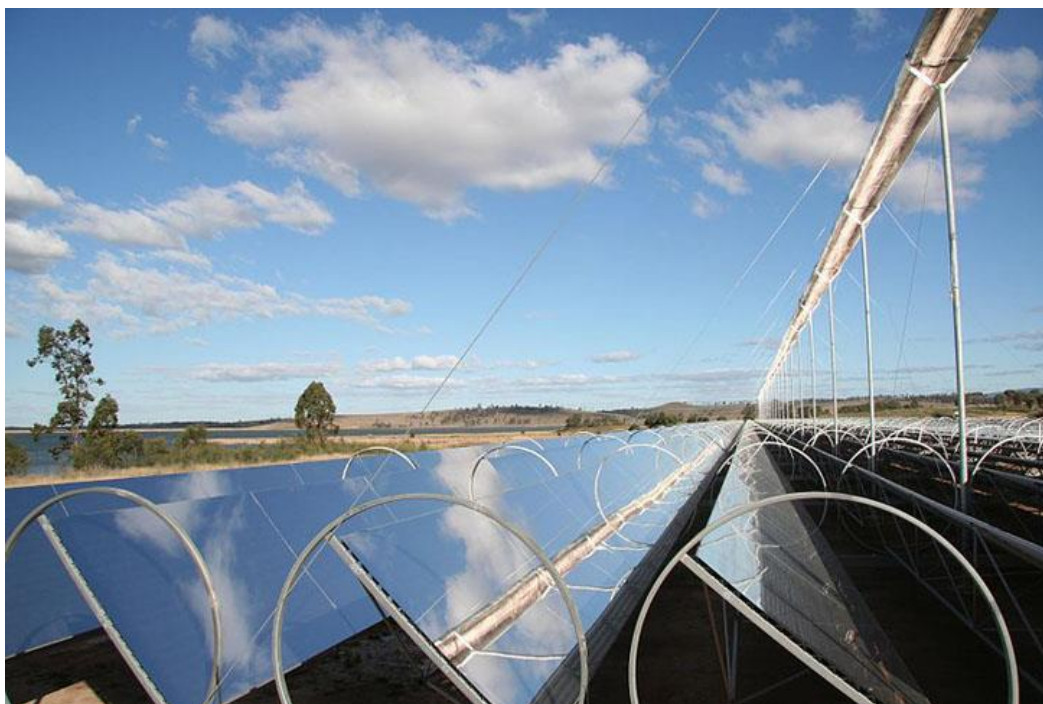
Εικόνα 3.3. Σύστημα Linear Fresnel Reflector
