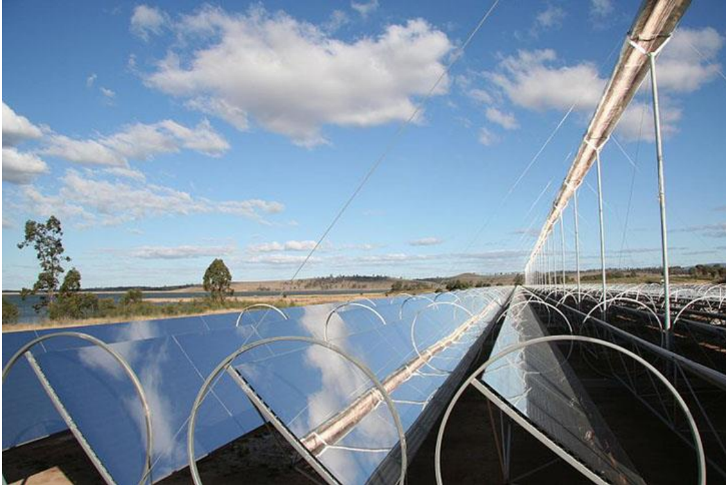
Εικόνα 3.3. Σύστημα Linear Fresnel Reflector
