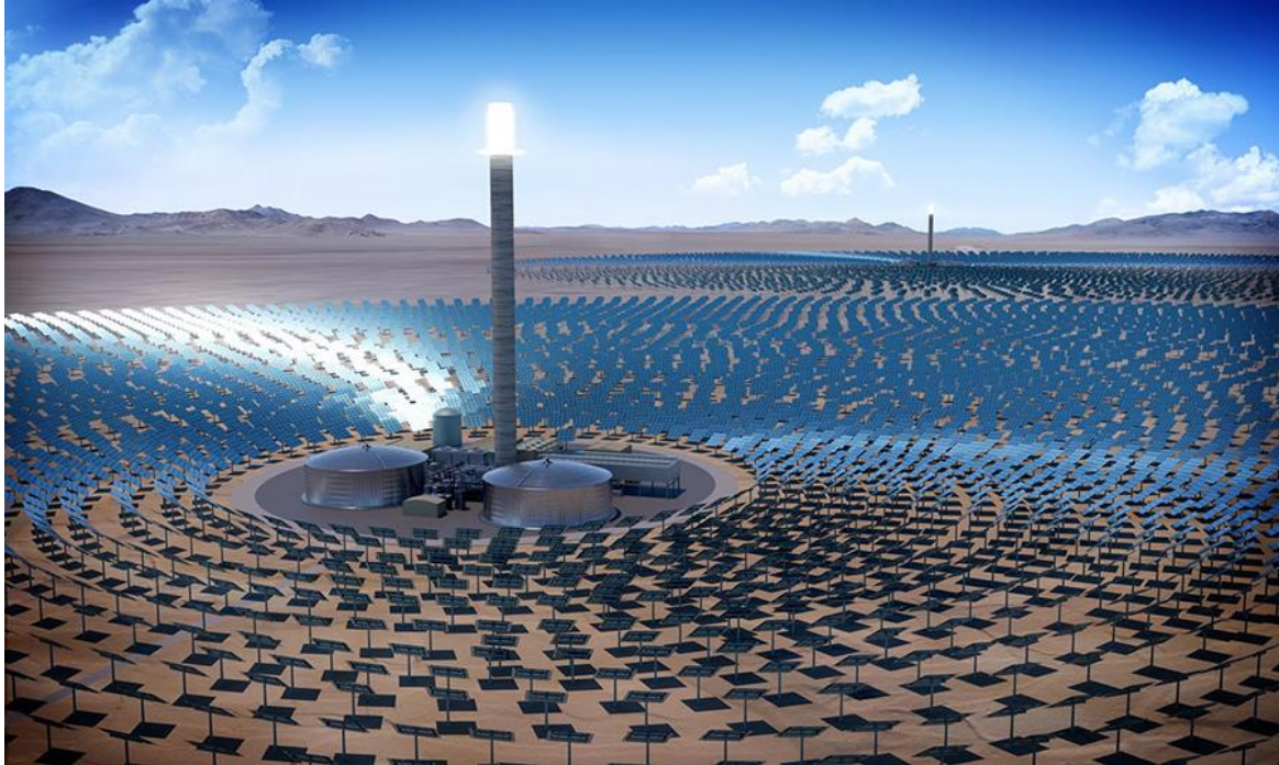
Εικόνα 3.2. Κεντρικός ηλιακός πύργος ισχύος
