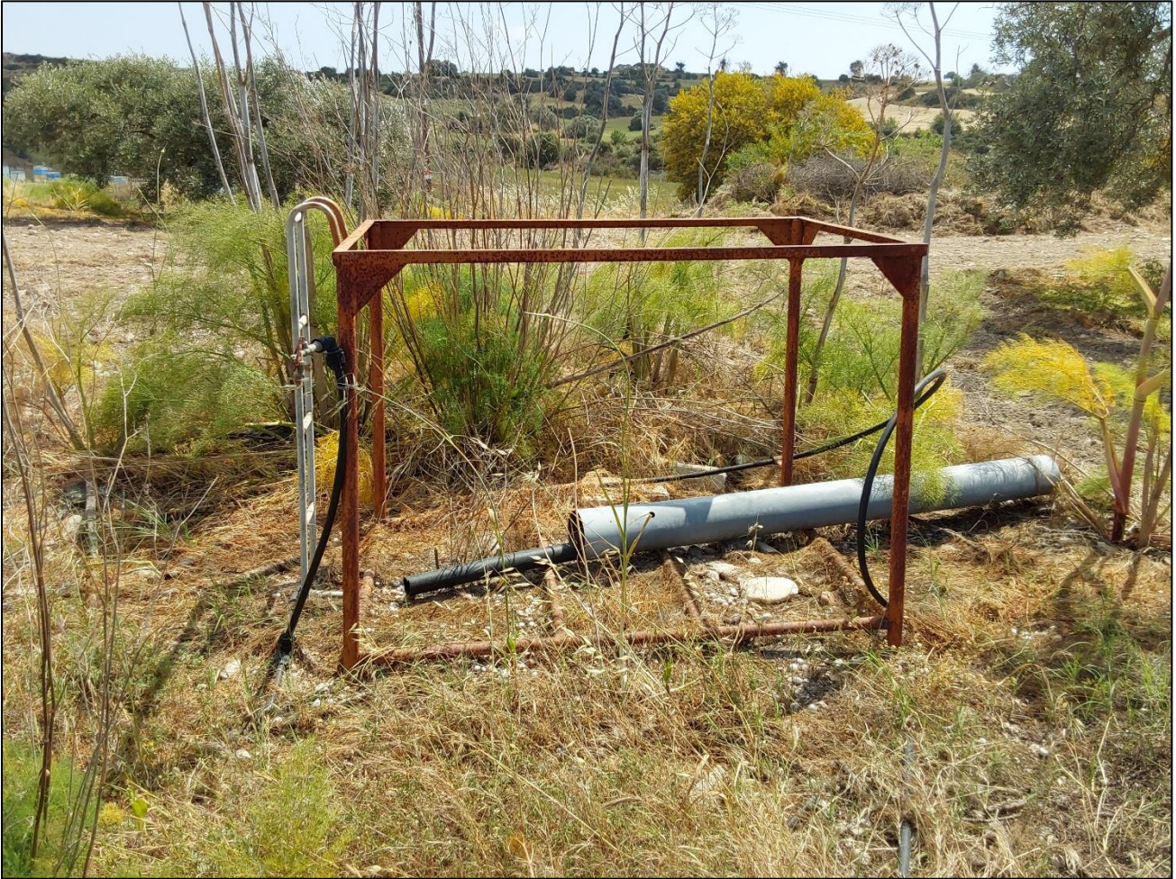
Εικόνα 6.6. Παροχή νερού στο νότιο τμήμα της ΑΠΜ (Aeoliki Ltd, 2023) - Σημείο 5
