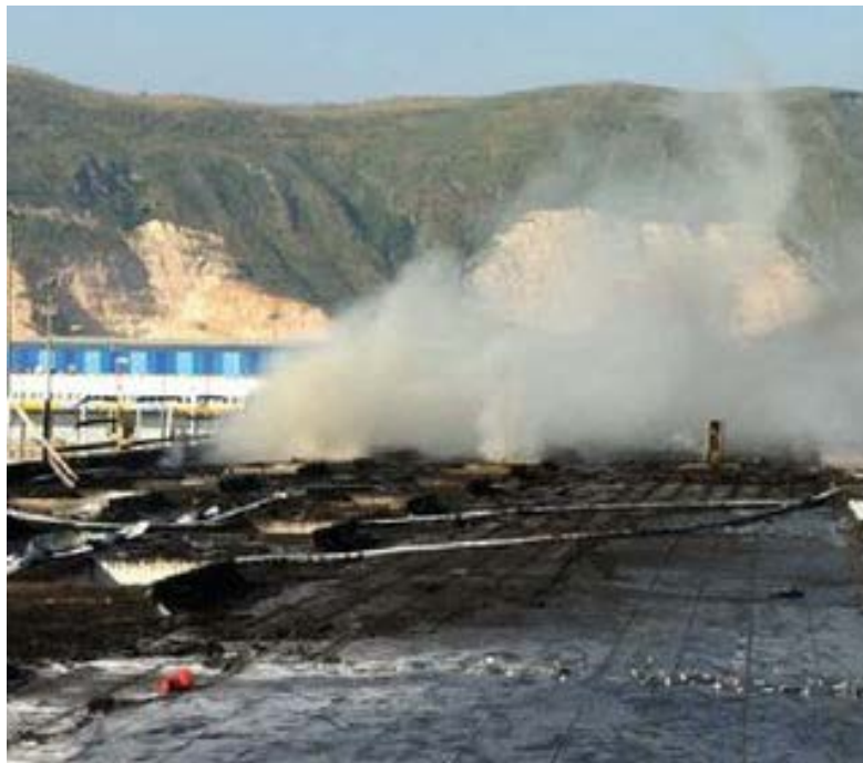
Εικόνα 8.6. Πυρκαγιά σε φωτοβολταϊκό πάρκο
