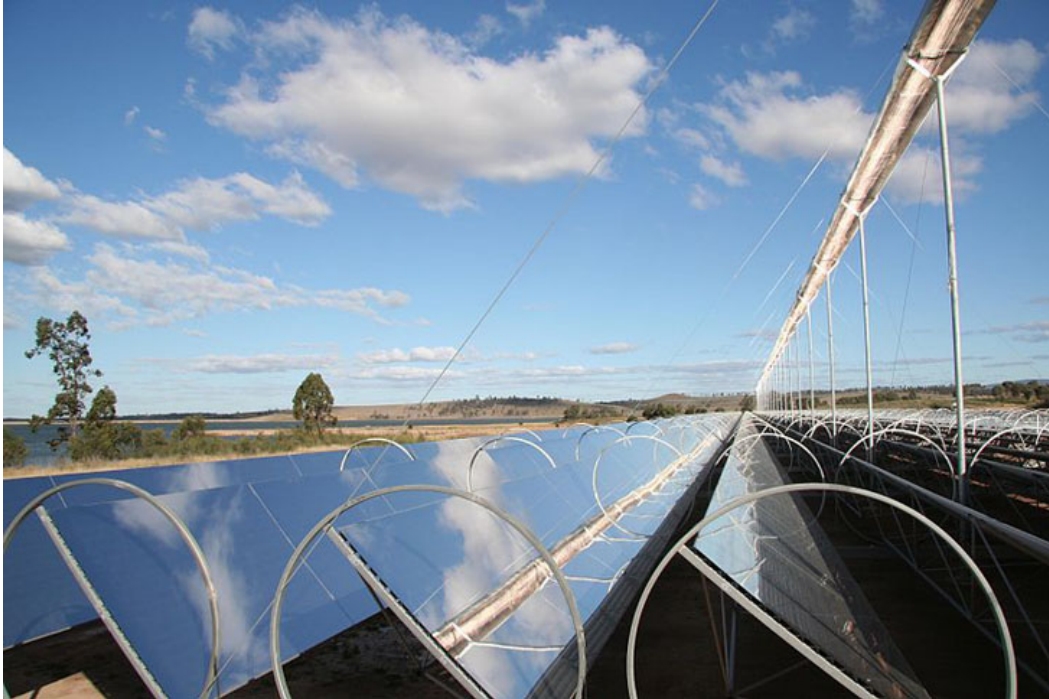
Εικόνα 3.3. Σύστημα Linear Fresnel Reflector
