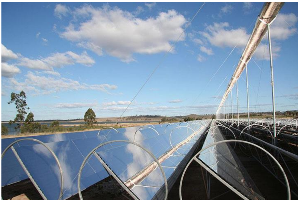
Εικόνα 3.3. Σύστημα Linear Fresnel Reflector
