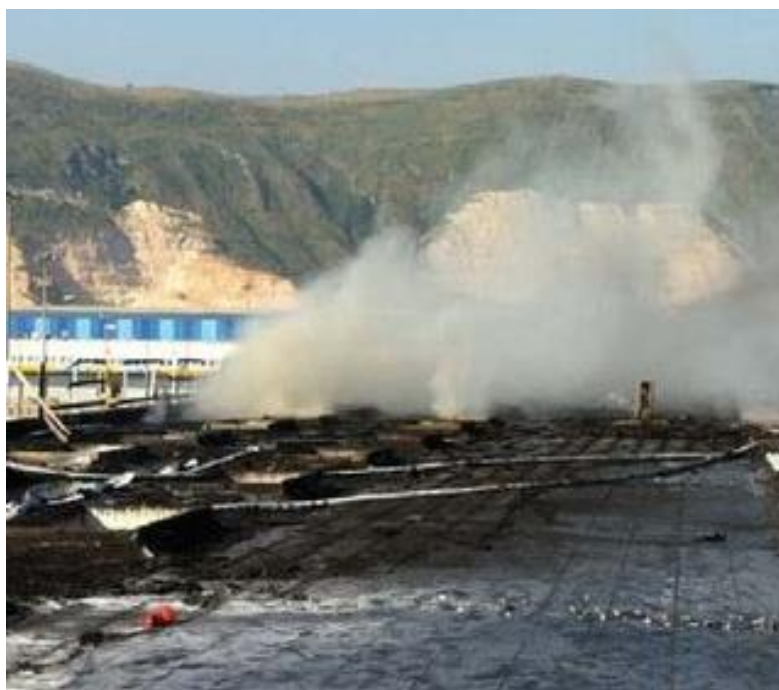
Εικόνα 8.5. Πυρκαγιά σε φωτοβολταϊκό πάρκο
