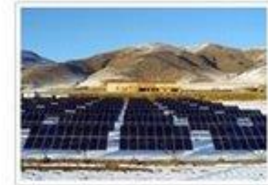
Σύστημα παρακολούθησης τροχιάς δύο αξόνων
