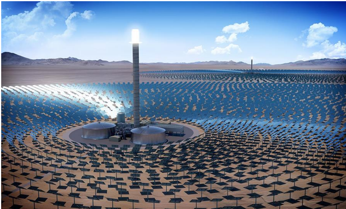
Εικόνα 3.2. Κεντρικός ηλιακός πύργος ισχύος
