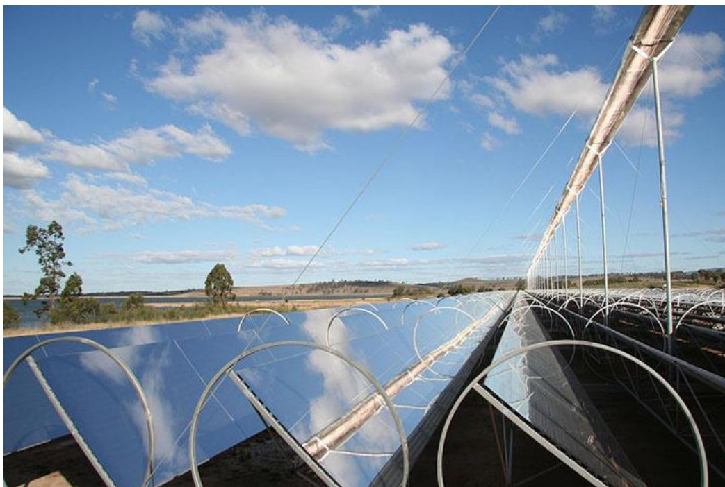
Εικόνα 3.3. Σύστημα Linear Fresnel Reflector
