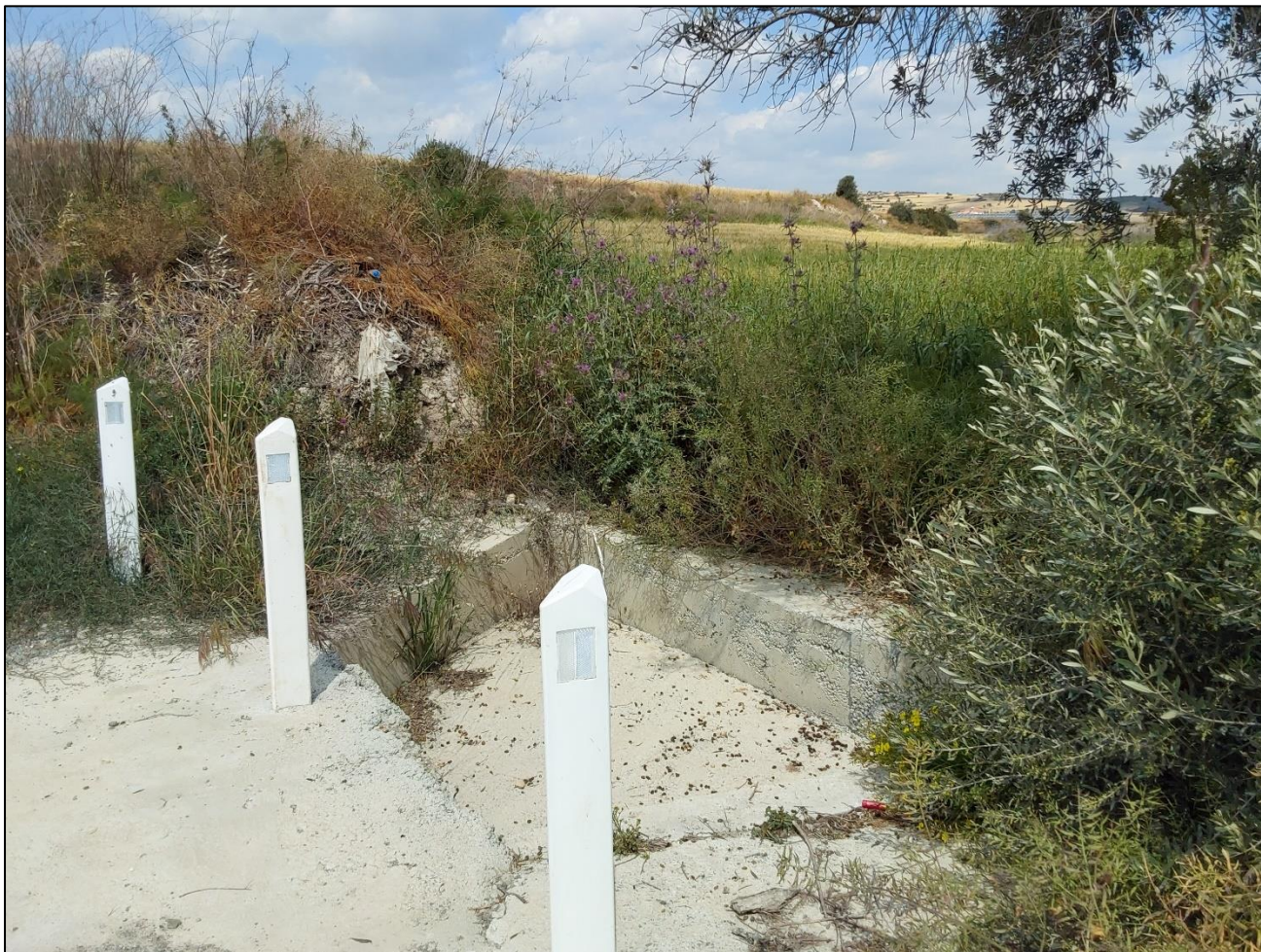
Εικόνα 6.3. Σημείο όδευσης οχετών όμβριων υδάτων (Aeoliki Ltd, 2023) - Σημείο 2
