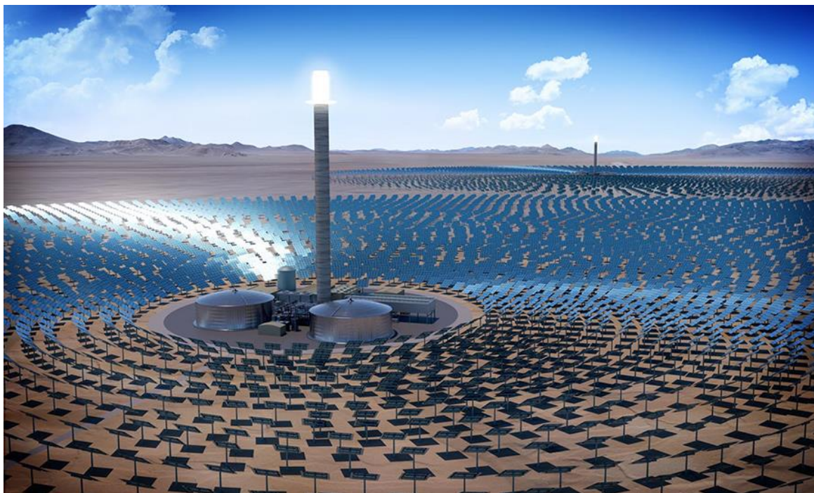
Εικόνα 3.2. Κεντρικός ηλιακός πύργος ισχύος
