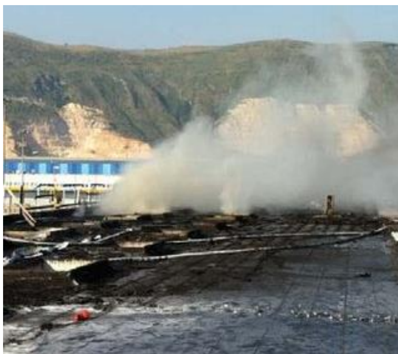
Εικόνα 8.5. Πυρκαγιά σε φωτοβολταϊκό πάρκο
