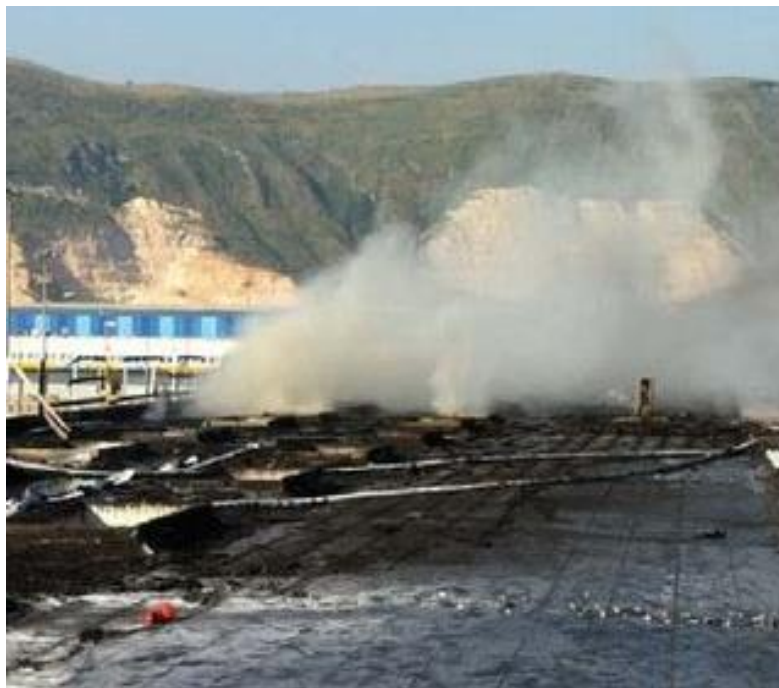
Εικόνα 8-5. Πυρκαγιά σε φωτοβολταϊκό πάρκο
