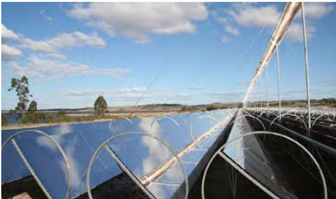
Εικόνα 4.2. Σύστημα Linear Fresnel Reflector
