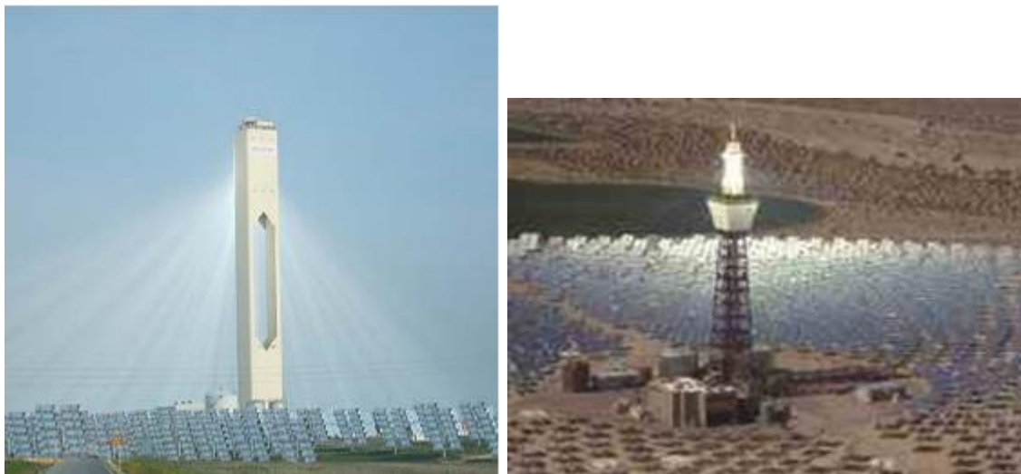
Εικόνα 4.1 Κεντρικός ηλιακός πύργος ισχύος
